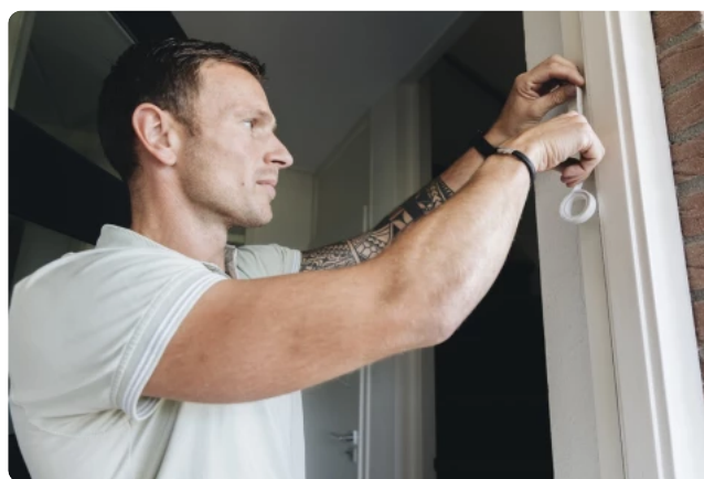
Het aanbrengen van tochtstrips is een voorbeeld van een kleine maar effectieve vorm van verduurzaming.
